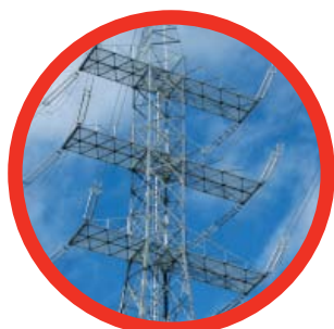
Construcción del apoyo más alto de Asturias, en Soto de Ribera
