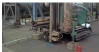
Trabajos de perforación
